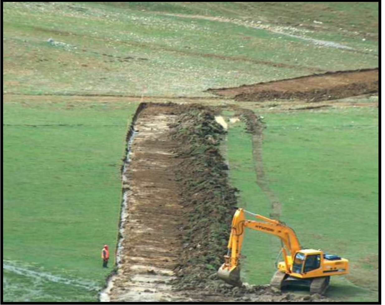
Şekil V.1.20.1. İnşaat Döneminde Bitkisel (üst) Toprağın Sıyırılması Çalışmaları
